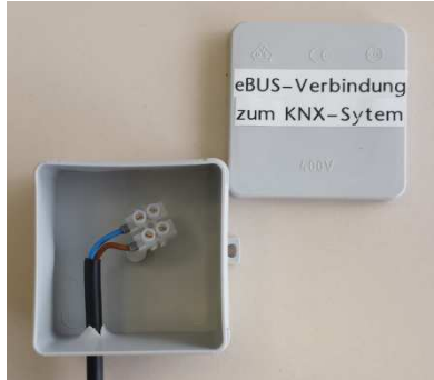
Abbildung 4: Abzweigdose zur Anbindung des ise eBUS Adapters an das Heizungssystem.
